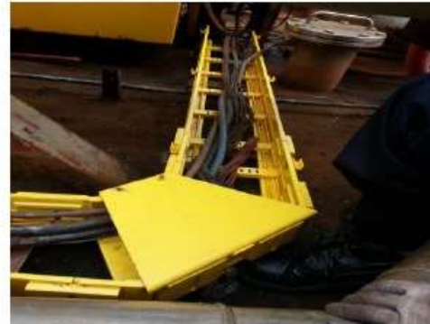
CORNER 부분 전선 설치
