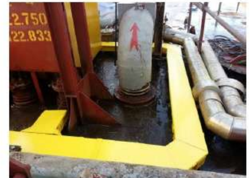
PC/ABS CABLE TRAY 설치 2시간 소요
