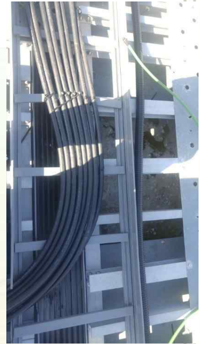
AC 전원 케이블 (전기자기장에 의한 올림현상없음 대지간 누설전류 감소효과)
