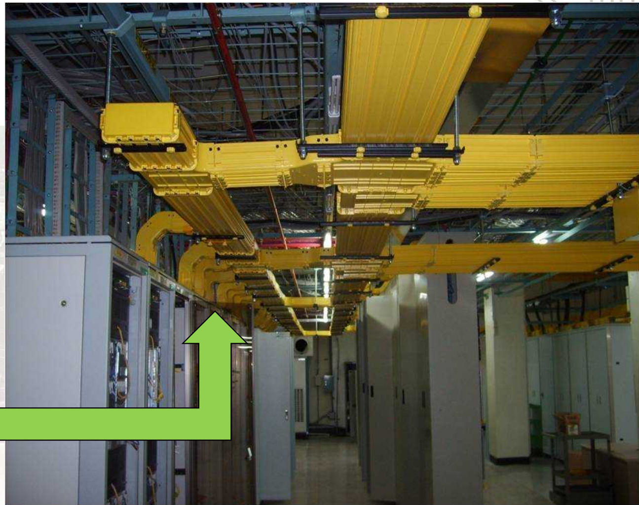
광 덕트 시스템 방식 (상단처리 방식)
