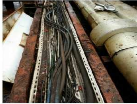
TRAY안에 PLASTIC TRAY가 이중으로 설치
