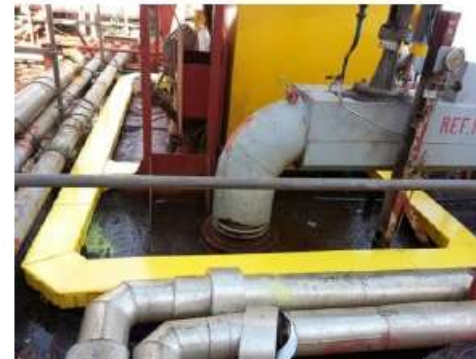
설치완료 후 COVER 안착
